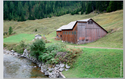
Ferrera, Ehemalige, provisorische Trafostation
